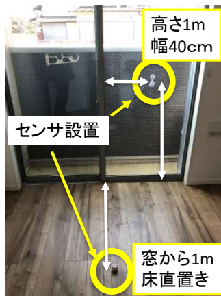
図 3 センサ設置例
