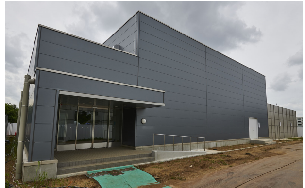
図 1 AI データセンタ棟 外観
