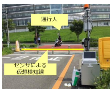
図 3 道路側装置 (可搬型使用時の様子)
