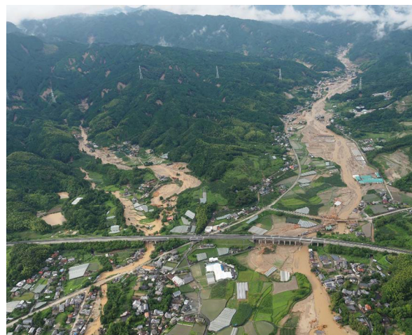
図 1 福岡県朝倉市（国土交通省九州地方整備局）
