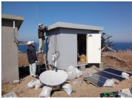
図3 衛星通信を用いた臨時観測点の例
