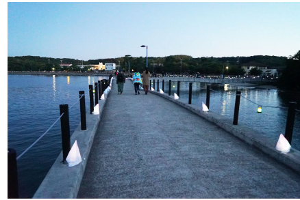
図 12 橋への「インタラクティブカラフルランタン」の設置
