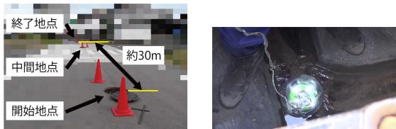
(a) 実験環境 (b) 管内に流した試作ノード 図 8 下水処理場における実験
