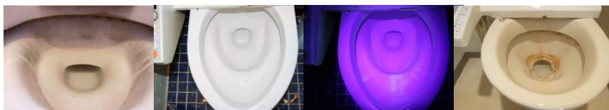
(1) 水垢汚れ (2) 尿汚れ (紫外線ライト無し) (3) 尿汚れ (紫外線ライト有り) (4) 尿石汚れ
