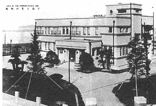
図-6 旧宇部工業会館（建設当時）
