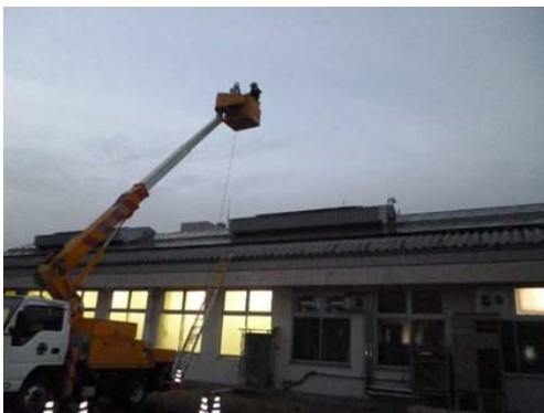
図 10 高所作業車を使用した撮影の様子
