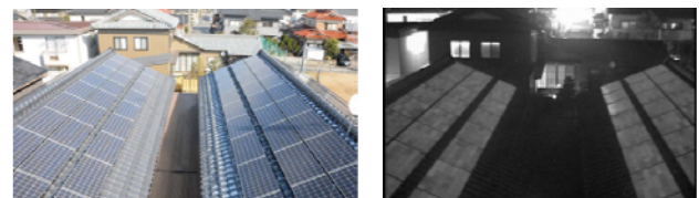
敷設状況(日中) 敷設状況(夜間 EL 発光中)
