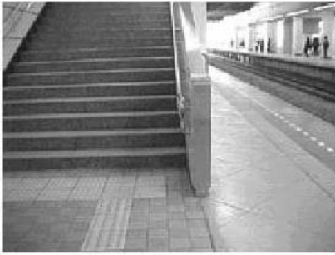
駅構内の上り階段
