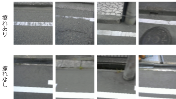
図 2 本研究で収集したデータの一部。各画像は、撮影された動画の各フレーム (1024×768 ピクセル) からランダムにクロッピングされて 224×224 ピクセルになっている。上段は擦れている白線を、下段は擦れていない白線を示している。
