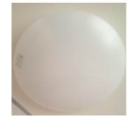
天井照明 (寝室)
