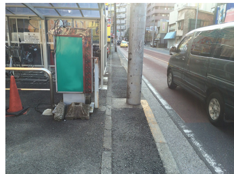
図 2 電柱が通行幅を狭めている歩道
