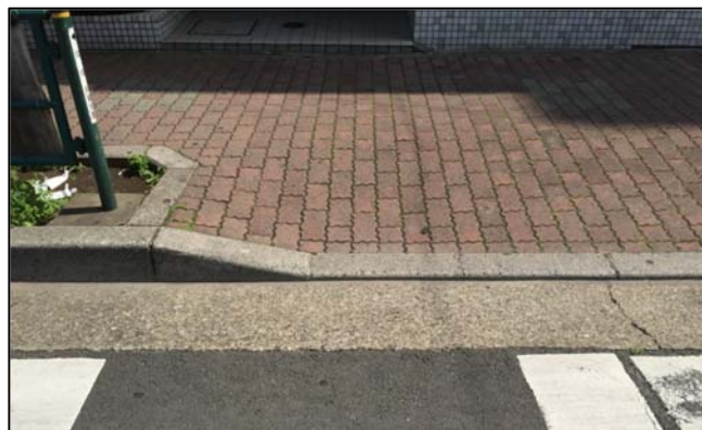
図1 歩道の切り下げによる段差やカント
