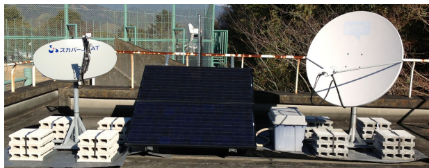
図 3. ステーションの外観
