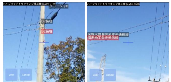
(b) 装柱パタン、クロージャ、通信線路の AR 表示
