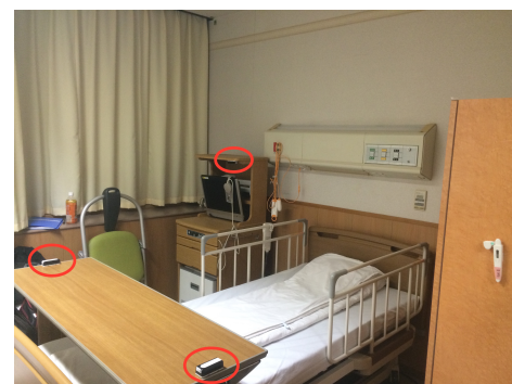
図 1 赤外線ビーコンの設置例 (病室)
