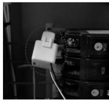
図 2 配電盤に設置された電流センサ
