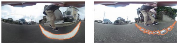
図8.路面標示の輪郭(左図:擦り切れなし, 右図:擦り切れあり)
