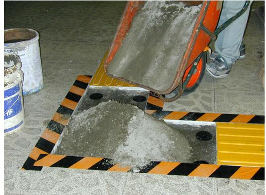
図 5 RFID タグの埋設状況
