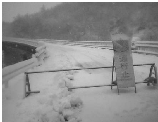
図 3 災害発生現場の写真例 Fig. 3 Photograph of disaster site.
