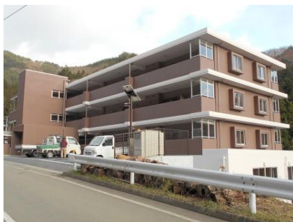
図 4.1 花露辺地区復興公営住宅[15]
