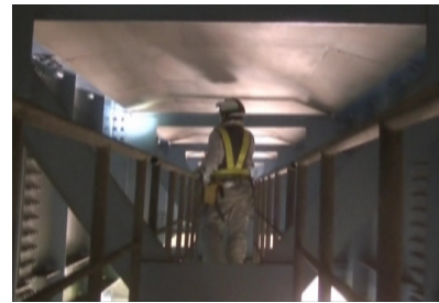
図 1 橋梁内の検査路での詳細点検の様子
