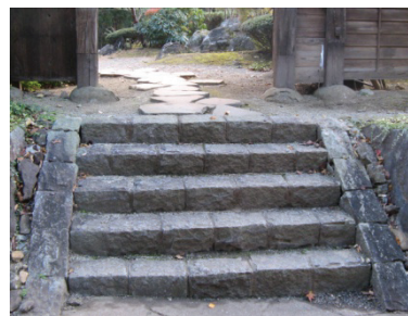
図 2 建物入口の段差
