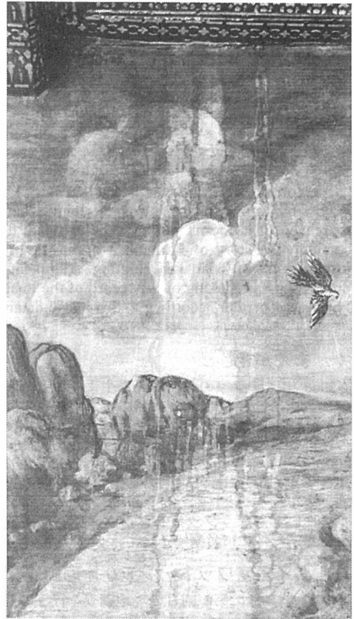
図4 修復を待つワット・プラケオ回廊の壁面状態
