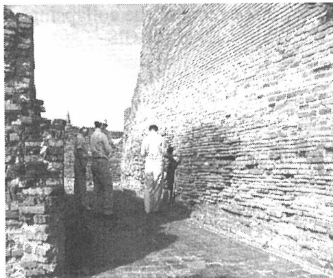
Fig 2 マハタート寺院の煉瓦建造物
