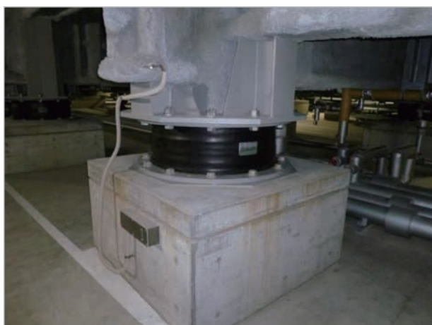
図-6 積層ゴム免震装置
